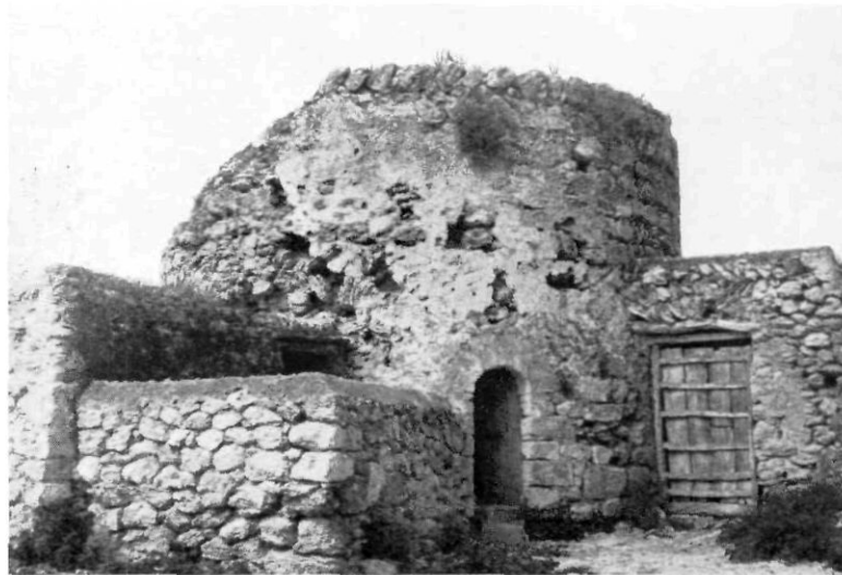
Torre d'En Basques. Darrerament ha estat restaurada.
