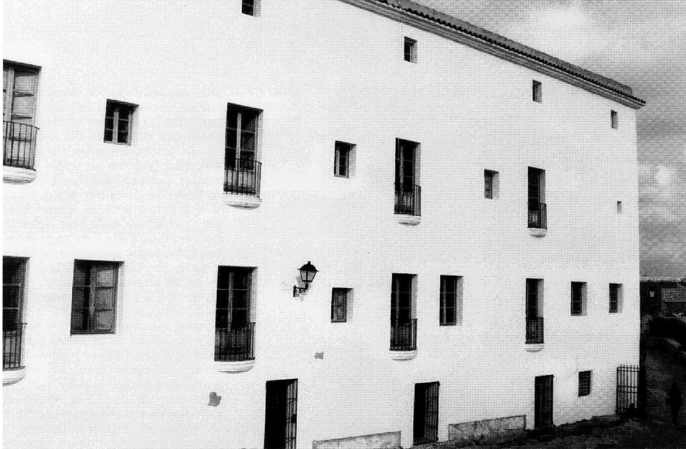
Antic convent dels dominics, ara Ajuntament de la ciutat d'Eivissa. El fet que des de la seua edificació fins a 1963 hagi allotjat pràcticament sempre escoles entre els seus murs el converteix en edifici emblemàtic de l'ensenyança eivissenca.
