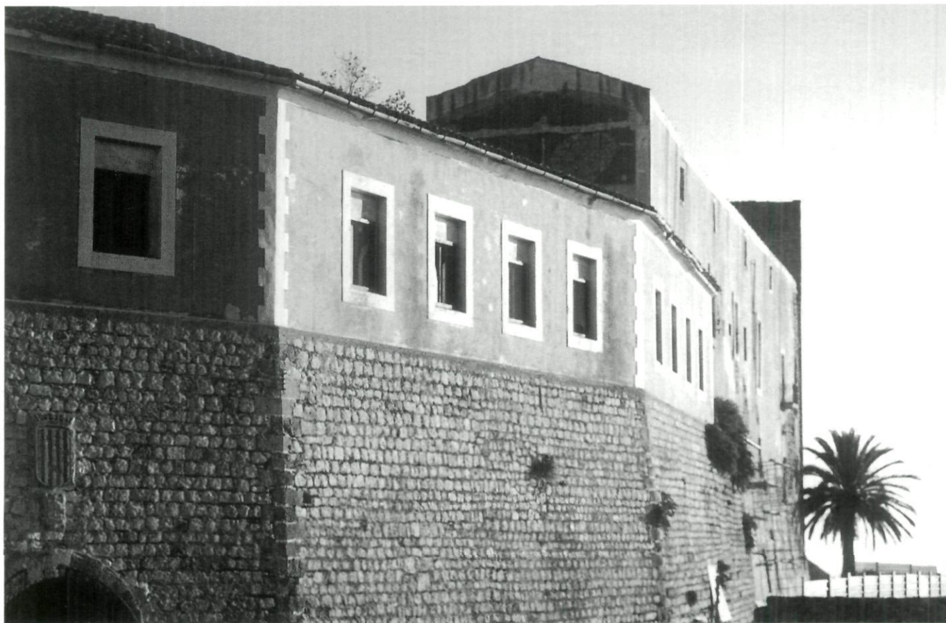
Murs de distintes èpoques al castell d'Eivissa. (Foto: revista EIVISSA.)
