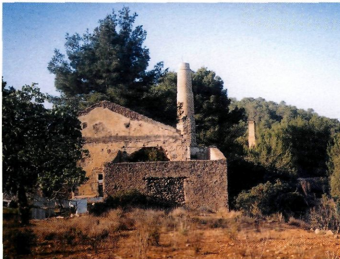
Detall de les instal·lacions de l'Argentera. (Foto: revista EIVISSA.)
