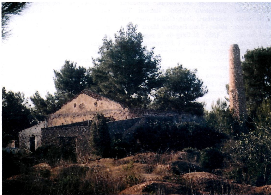
Estat actual d'algunes instal·lacions auxiliars de les mines. (Foto: revista EIVISSA.)
