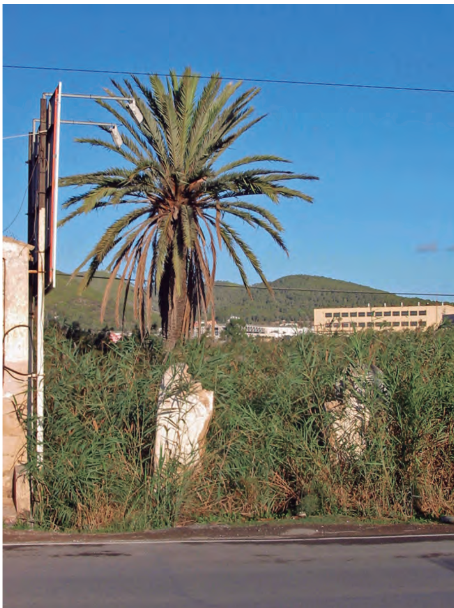
El portal de la feixa de can Guerxo és una bona mostra de l'estat de degradació del sector de feixes del Pla de Vila (fotografia: Enric Ribes).
