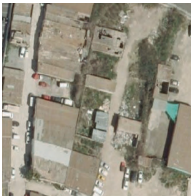
Imatge 4. Exemple de l'ús definit com d'edificacions en mal estat de conservació amb usos industrials, de serveis o abandonades.
