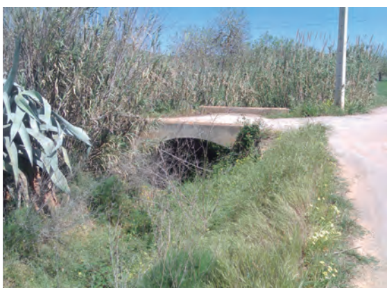
De dalt a baix, per aquest ordre: Figura 13: Vegetació al llit del torrent des Regueró. Figura 14: Llit del torrent de Buscastell tapat de vegetació. Figura 15: Llit del torrent de Buscastell tapat de vegetació seca. Figura 16: Llit del torrent de Buscastell cobert de vegetació.
