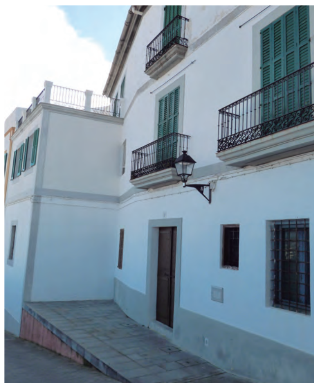
Imatge parcial actual de l'antiga casa anomenada «casa del doctor Isidro», ara casa Roman, al carrer de Pere Tur, 9.
