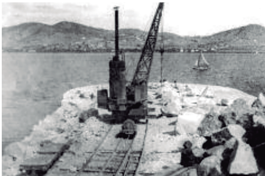
Espigó del port en construcció a finals del segle XIX. Arxiu d'Imatge i So Municipal d'Eivissa.
