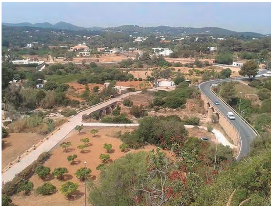
Carretera de Santa Eulària (els dos ponts). El riu de Santa Eulària ha obligat a la construcció de dos ponts moderns, ja que el vell, dels primers anys del segle xx, va esdevenir insuficient pel fort augment del trànsit avançat el segle.
